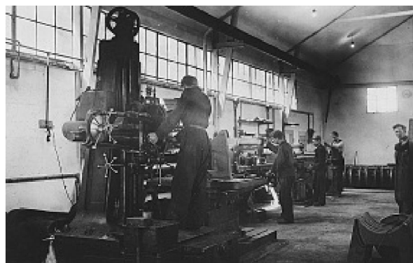
Det nye maskinværksted på Vordingborgvej 32A.
