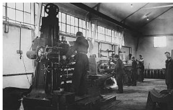
Det nye maskinværksted på Vordingborgvej 32A.
